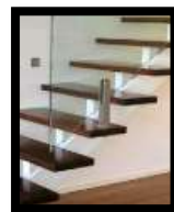
شكل (25) تثبيت الدرازين الزجاجي أعلى السلم بقوائم معدنية
