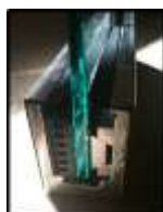
شكل (22) قطاع المسار الجانبي للدرازين الزجاجي
